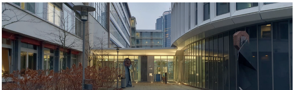
Skulpturen vor dem neuen Gebäude 10.
